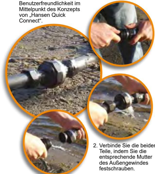
2. Verbinde Sie die beiden Teile, indem Sie die entsprechende Mutter des Außengewindes festschrauben.
